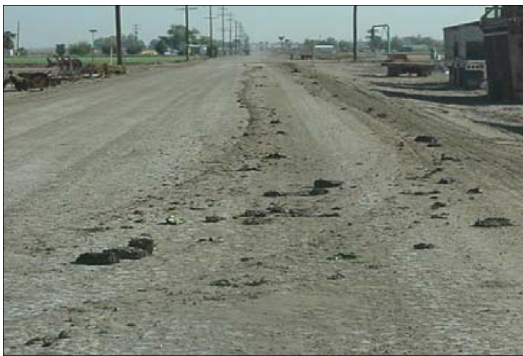
Ejemplo de basura, escombros y tierra que no fue eliminado después de las actividades agrícolas.
