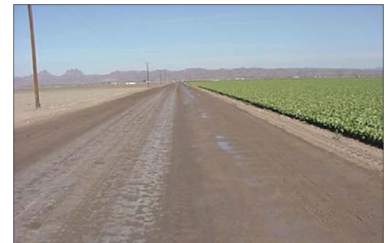
Las carreteras del Condado se mantienen rutinariamente por Obras Públicas del Condado de Yuma. El riego excesivo puede causar daños en las carreteras y accidentes
